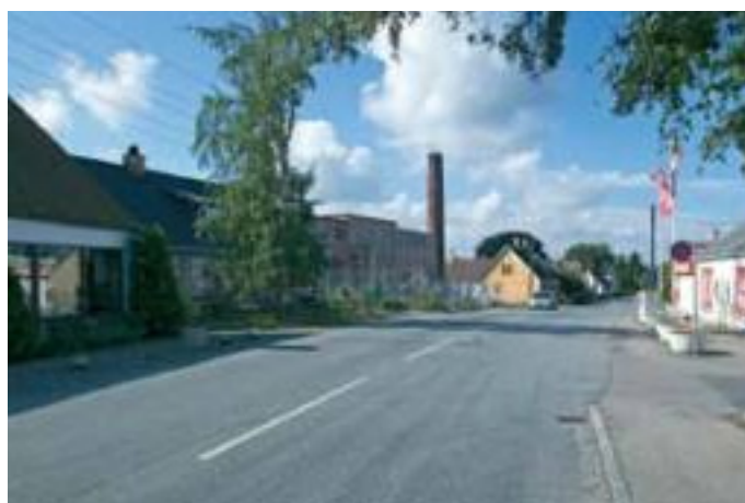
Området ved brugsen og mejeriet opleves som Fanefjordgades "centrum" og markeres flot af skorstenen. Mejeriet benyttes ikke idag, da dens stand er meget dårlig. Den forsømte bygning præger helhedsoplevelsen af stedet.
